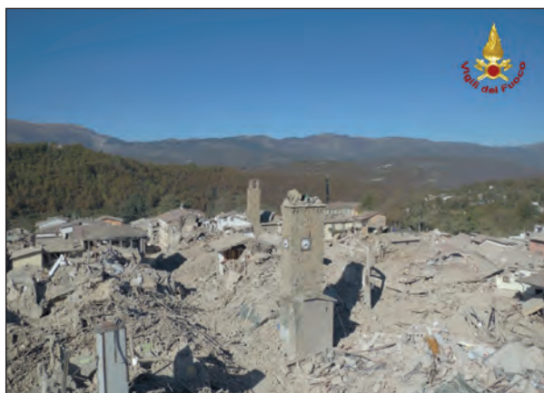
Figura 1 – Vedute aeree di Amatrice (sinistra) e Norcia (a destra), riprese all'inizio del novembre 2016. Ad Amatrice per la scossa del 24 agosto è stato assegnato un X-XI grado della scala MCS contro il VI di Norcia. Dopo la scossa del 30 ottobre Amatrice è salita all'XI; Norcia, che si è trovata molto vicina a questa seconda e più forte scossa, è salita all'VIII-IX. Complessivamente gli effetti cumulati delle tre scosse più forti hanno lasciato ben pochi edifici in piedi ad Amatrice; al contrario Norcia appare decisamente poco danneggiata, con la sola importante eccezione della chiesa di San Benedetto (di cui si vede bene la facciata, ancora in piedi). Eccezionale la prestazione del Palazzo Comunale e della relativa torre, edifici rinforzati in modo evidentemente efficace dopo i terremoti che hanno colpito Norcia nel 1859 e nel 1979.
