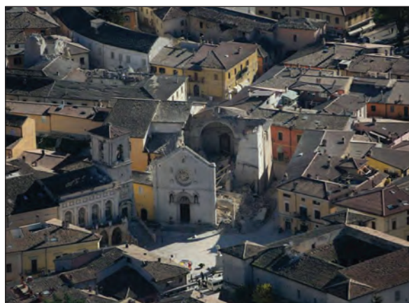
Figura 1 – Vedute aeree di Amatrice (sinistra) e Norcia (a destra), riprese all'inizio del novembre 2016. Ad Amatrice per la scossa del 24 agosto è stato assegnato un X-XI grado della scala MCS contro il VI di Norcia. Dopo la scossa del 30 ottobre Amatrice è salita all'XI; Norcia, che si è trovata molto vicina a questa seconda e più forte scossa, è salita all'VIII-IX. Complessivamente gli effetti cumulati delle tre scosse più forti hanno lasciato ben pochi edifici in piedi ad Amatrice; al contrario Norcia appare decisamente poco danneggiata, con la sola importante eccezione della chiesa di San Benedetto (di cui si vede bene la facciata, ancora in piedi). Eccezionale la prestazione del Palazzo Comunale e della relativa torre, edifici rinforzati in modo evidentemente efficace dopo i terremoti che hanno colpito Norcia nel 1859 e nel 1979.
